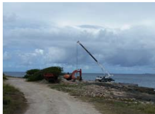
Travaux du ponton de débarquement (A. Levesque)
